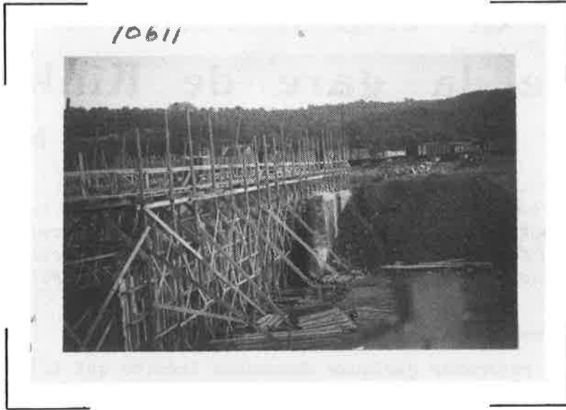
Construction du coffrage pour le pont-tube routier. On aperçoit encore une culée de l'ancien viaduc dans lequel passaient les trolleybus.
